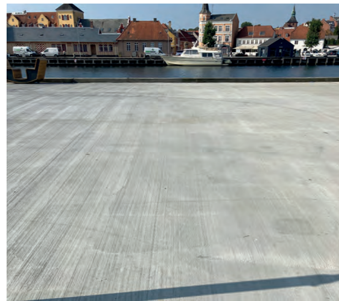
Udtræningskaj, Frederikssø, 2021 In situ støbt og kostet beton i store overflader for at understøtte det industrielle havneudtryk og havnens store skala.
